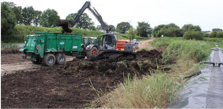
Bilder der Beet-Räumung aus August 2017 in Baddeckenstedt: Der Bagger verlädt die dunkle Klärschlammerte auf den Transporter. Unten: Im Damm wurde ein Loch geschaffen, durch das Bagger und Transporter ins Beet hineinfahren können. Die Zuwegung zum Beet wird zur Räumung mit Schotter stabilisiert, damit die Transporte mit den schweren Maschinen erfolgen können.
