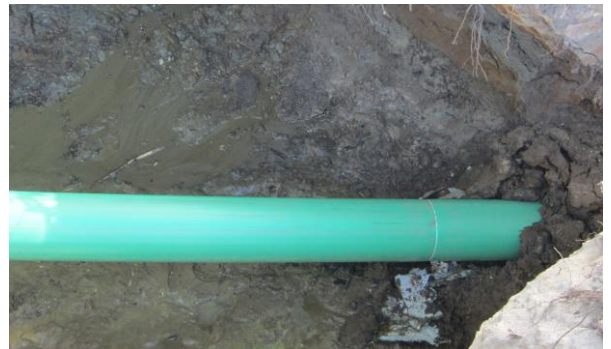
Das neue Rohr wird in das bestehende Zementrohr eingezogen.
