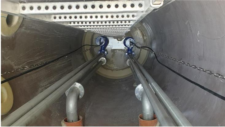
Blick in die Tiefe des neuen Schachts: Unten sind die beiden Tauchpumpen zu sehen, die das Abwasser zur Reinigung weiterleiten.
