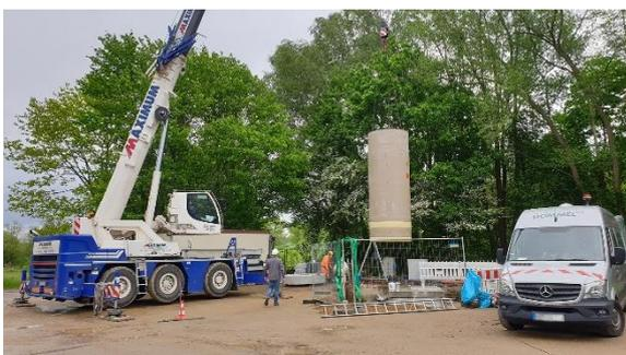
Der neue Zulaufschacht am Haken: 1,80 Meter im Durchmesser und 5,25 Meter lang wurde er in das bestehende unterirdische Bauwerk eingepasst. Der monolithisch, also in einem Einzelstück ausgeführte Schacht besteht aus Kunststoff und in einer Betonhülle.
